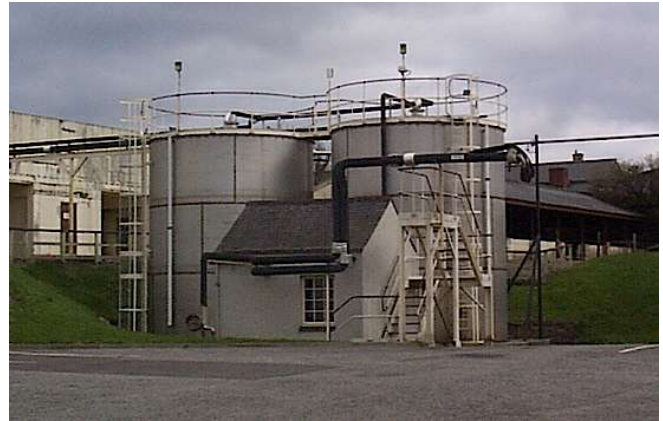
Tankerabfüllanlage von Craigellachie
