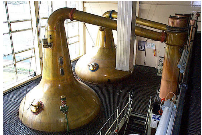
Wash- und Spirit Still mit Kondensatoren
