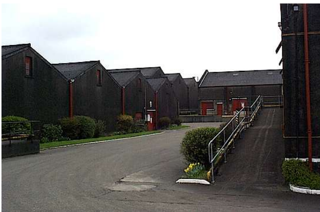
Lagerhäuser von Glenburgie
