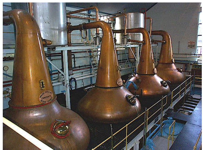
Brennblasen und Kondensatoren
