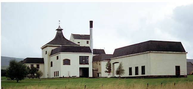
Außenansicht von Braeval
