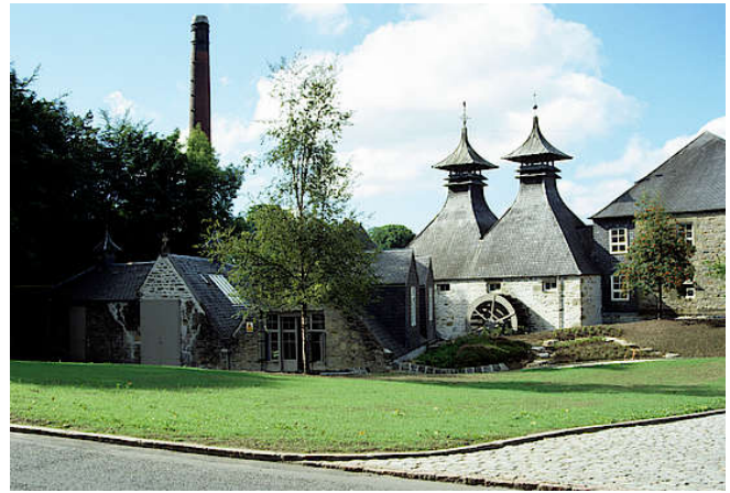
Außenansicht von Strathisla
