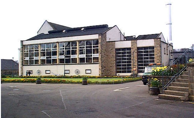
Brennhaus von Linkwood
